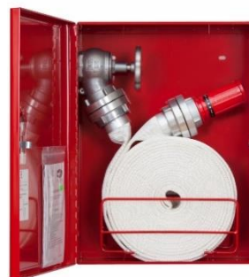
HYDRANT WEWNĘTRZNY 52 (z wężem płaskoskładanym)
